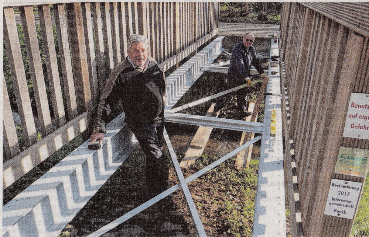
Hubert Mones (links) und Friedhelm Schmitz haben in wochenlanger Arbeit eine neue Unterkonstruktion für die Fußgängerbrücke über das Beeckfließ gebaut. Foto: Udo Stüßer
