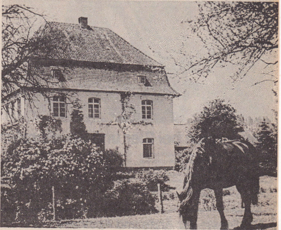
Eines der vielen Fotos des Buches: das Haus Beeck vor der Zerstörung um 1937.
